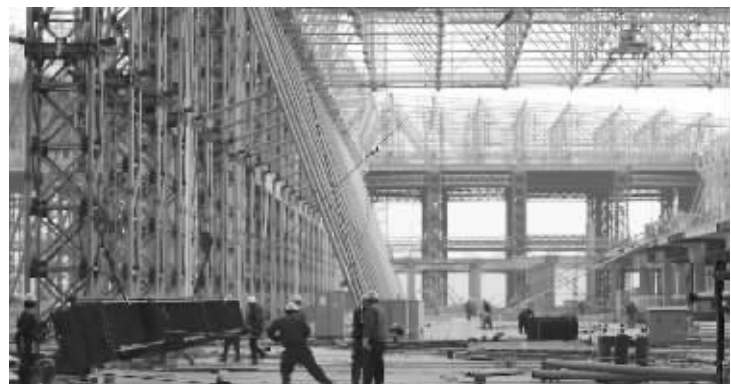
南京火车南站,工人正在加紧施工
