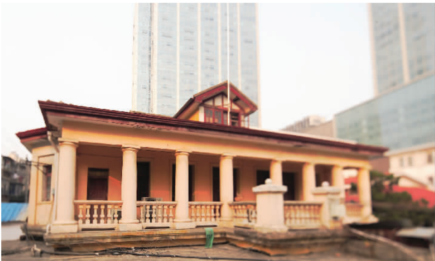
二层南面有宽阔的阳台走道，有8根罗马柱支撑
