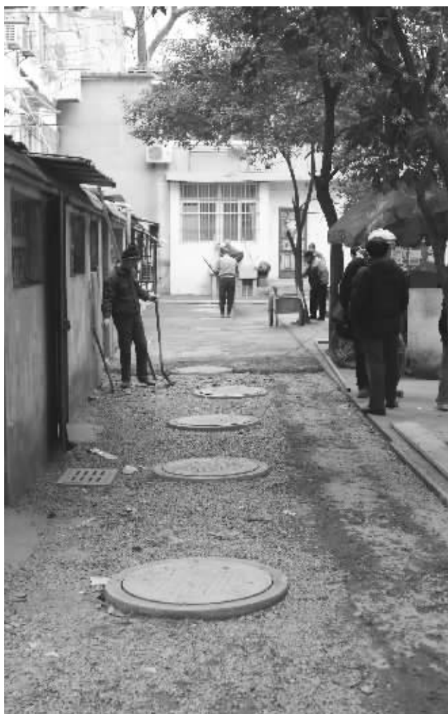
居民楼前密布窨井盖 快报记者 孙玉春 摄
