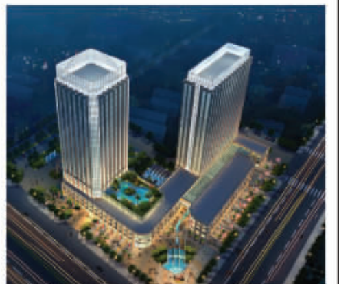
安徽明光世纪缘国际酒店 正在建设中
