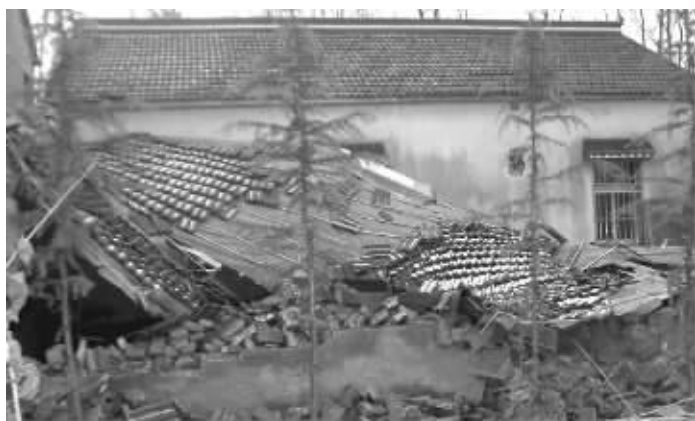
城管在没有通知自拆的情况下，直接拆掉了余道顺家的违建
