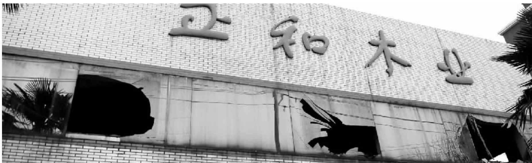
正和木业公司一楼房的玻璃被震碎 快报记者 施向辉 摄
