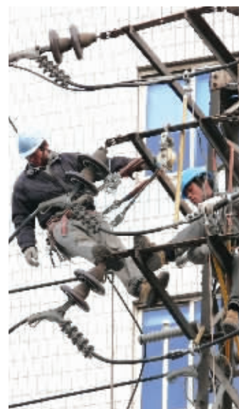
高压线起火,工作人员正在抢修 通讯员 沈婧婧 摄
