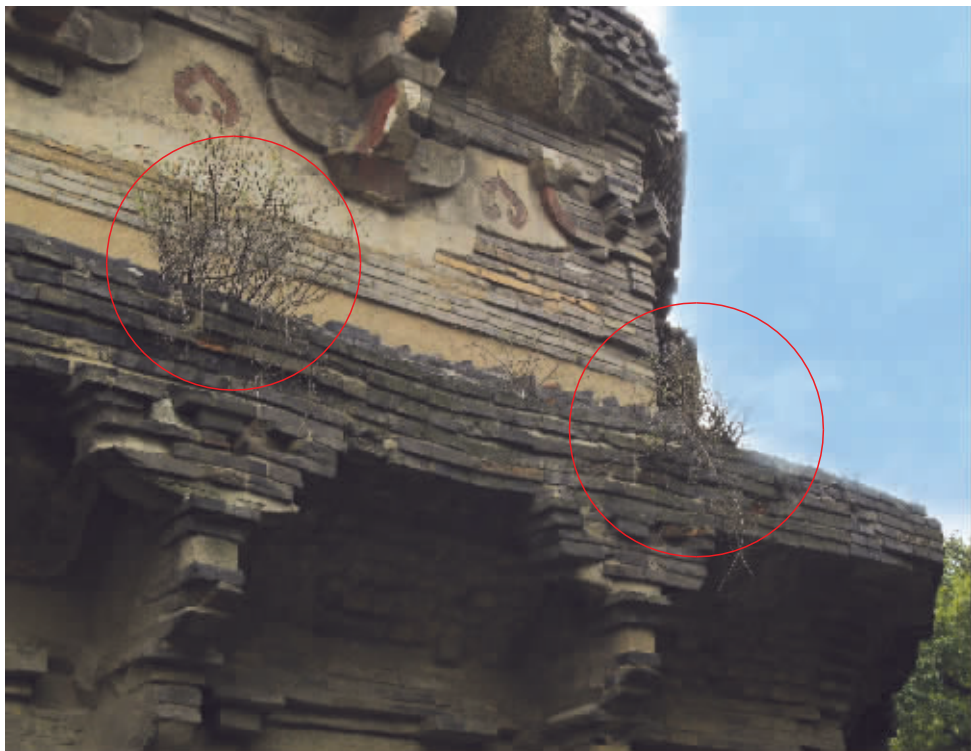
残损的塔檐上长着许多杂草和小树,给塔身的稳固带来隐患
