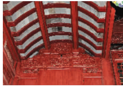
结构精致的屋顶保存完好
