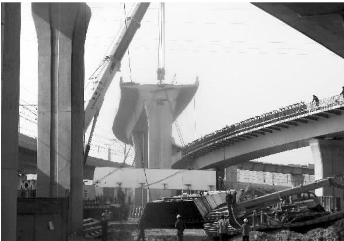
钢箱梁重达180吨，只能被切成四段，分段吊运
