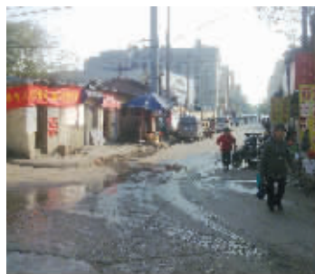
路口全部都是污水
