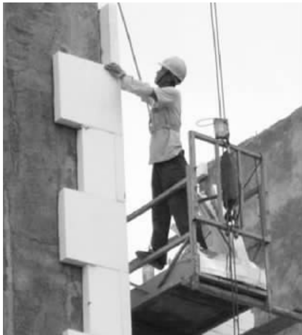
一位工人正在安装外墙保温材料 资料图片
