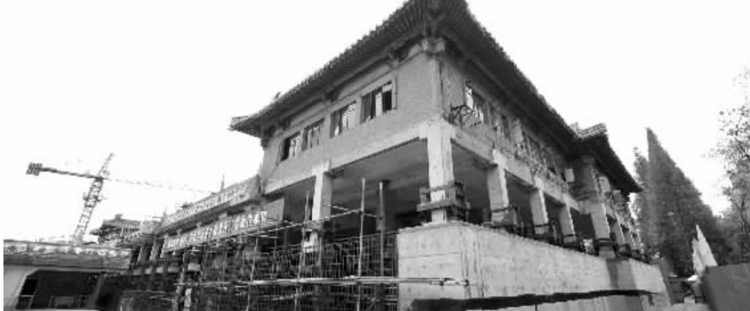
11月15日,南京博物院老大殿加固顶升工程正在进行,老大殿将整体增高3米 快报记者 赵杰 摄
