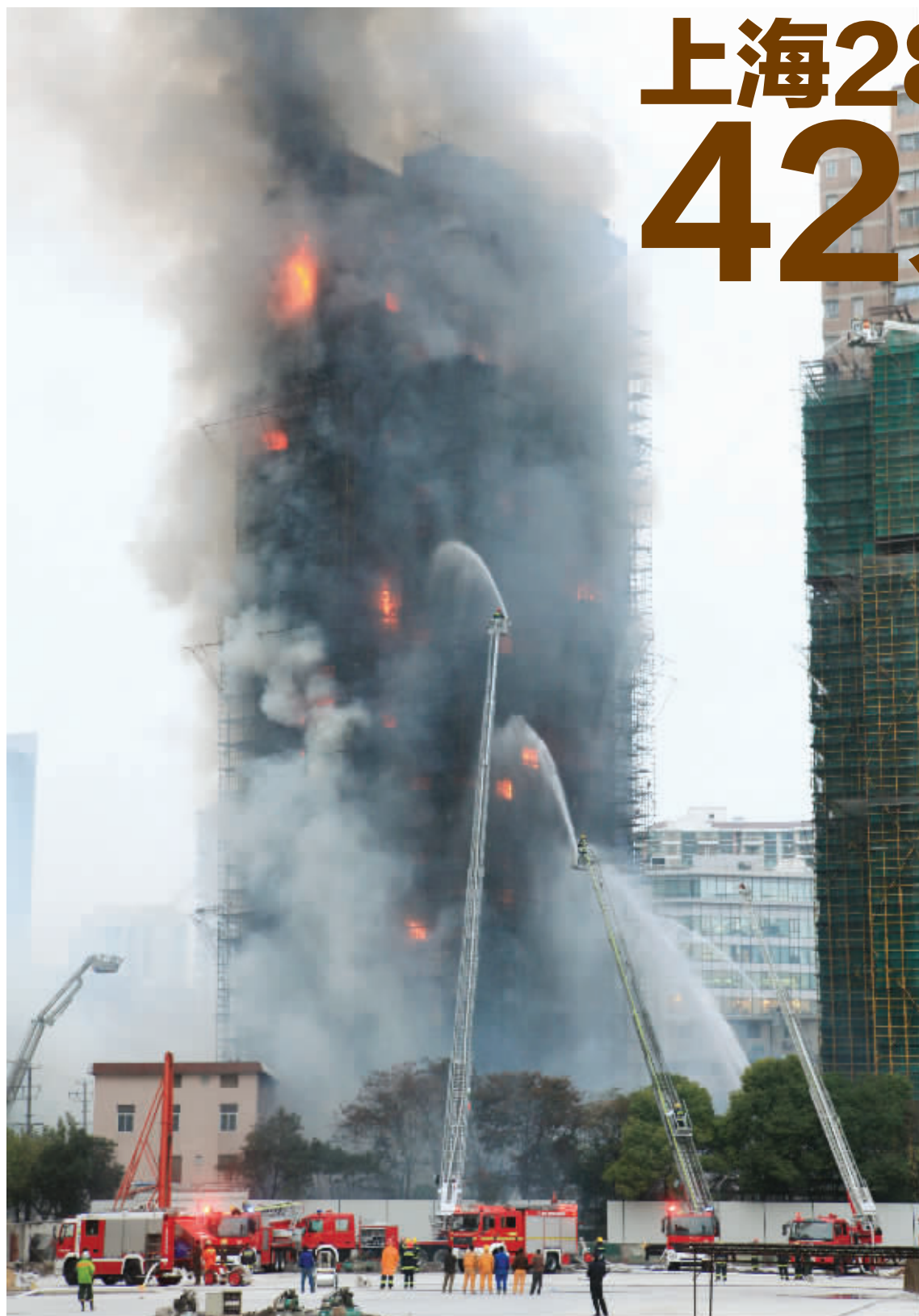
昨日14时15分许,大楼起火,消防队员正在火灾现场奋力灭火,起火原因正在调查中 IC图
