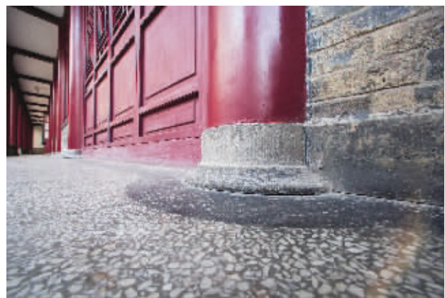
房屋和地面经过重新修缮
