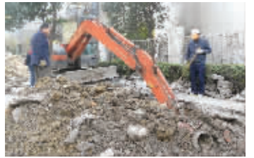
抢修人员用挖掘机挖开破裂的管道
