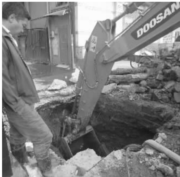
自来水公司扒开路面寻找漏水点
