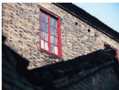
屋檐下留有排气孔,满足养蚕的需要
