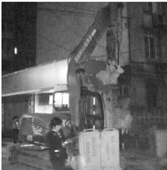
雨污分流工地,挖掘机长臂夜间高高升起
