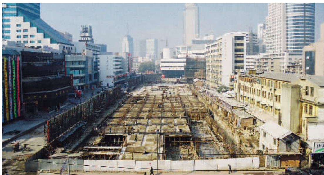
正洪街人防工程施工现场
