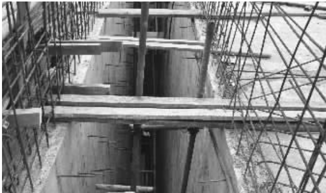
4名工人就是在这个一米左右宽的缝隙下粘贴防水卷材
