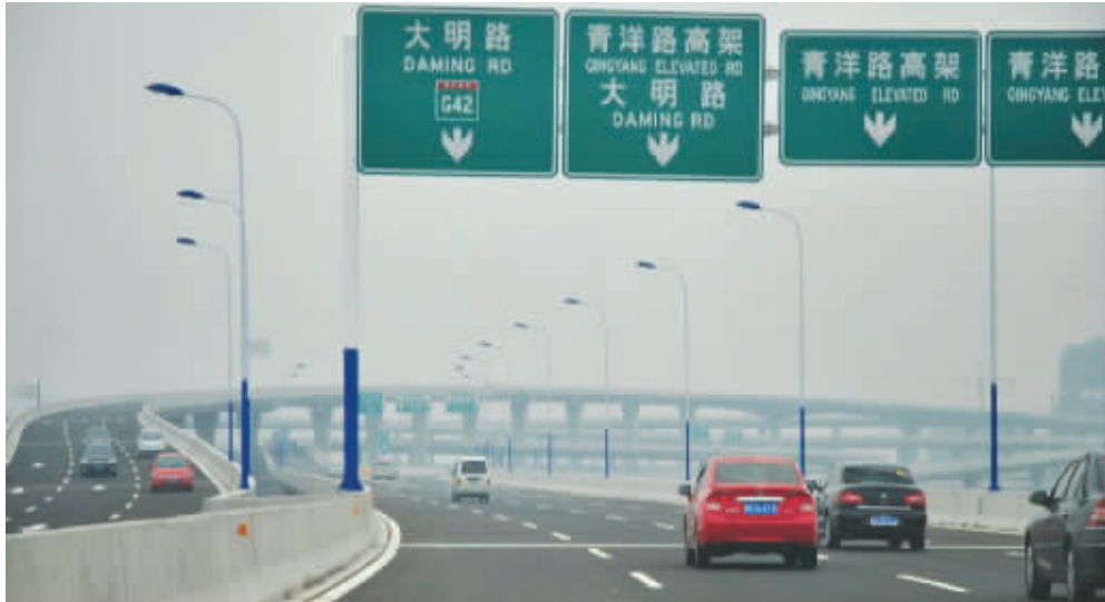
二期高架的开通,大大缓解了市区交通压力
