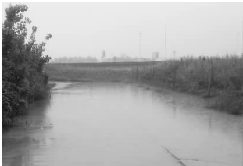
通往地铁金马路站的这条水泥路没有路灯,而且一下雨就淹
