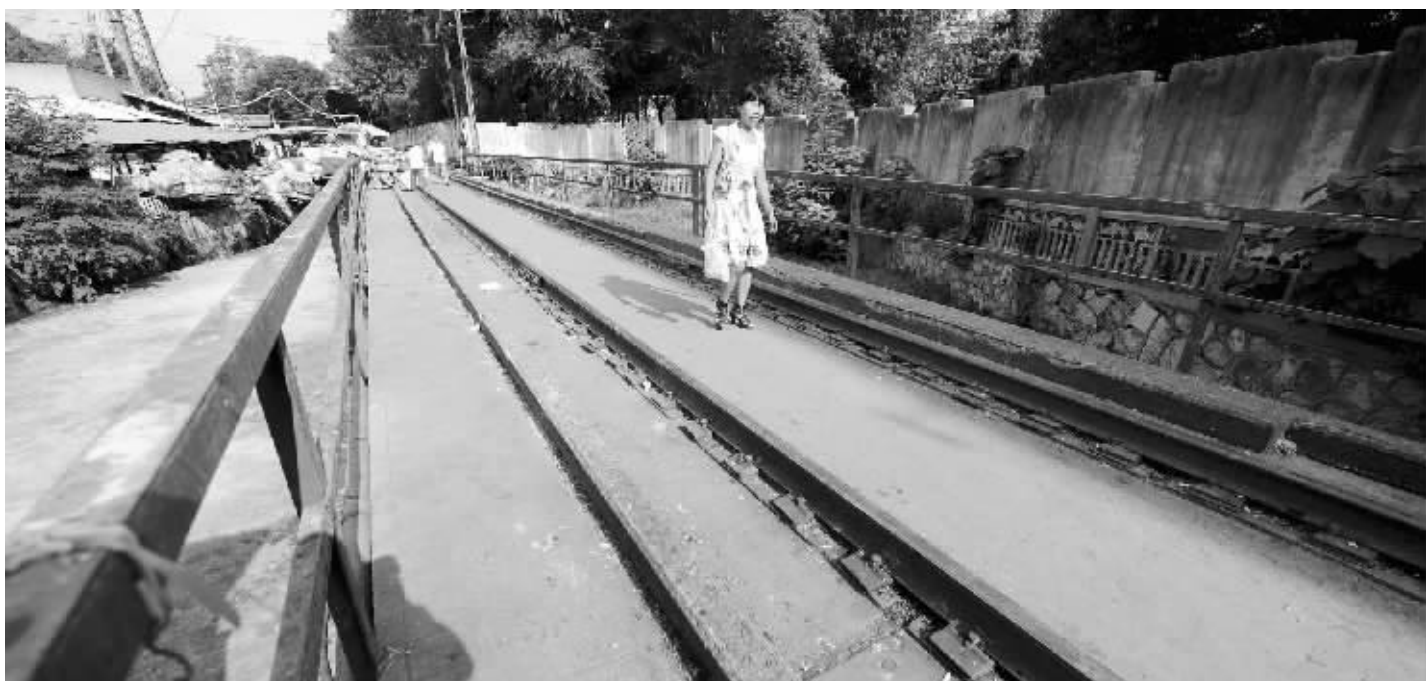
“最后”的铁路桥还能存在多久?
