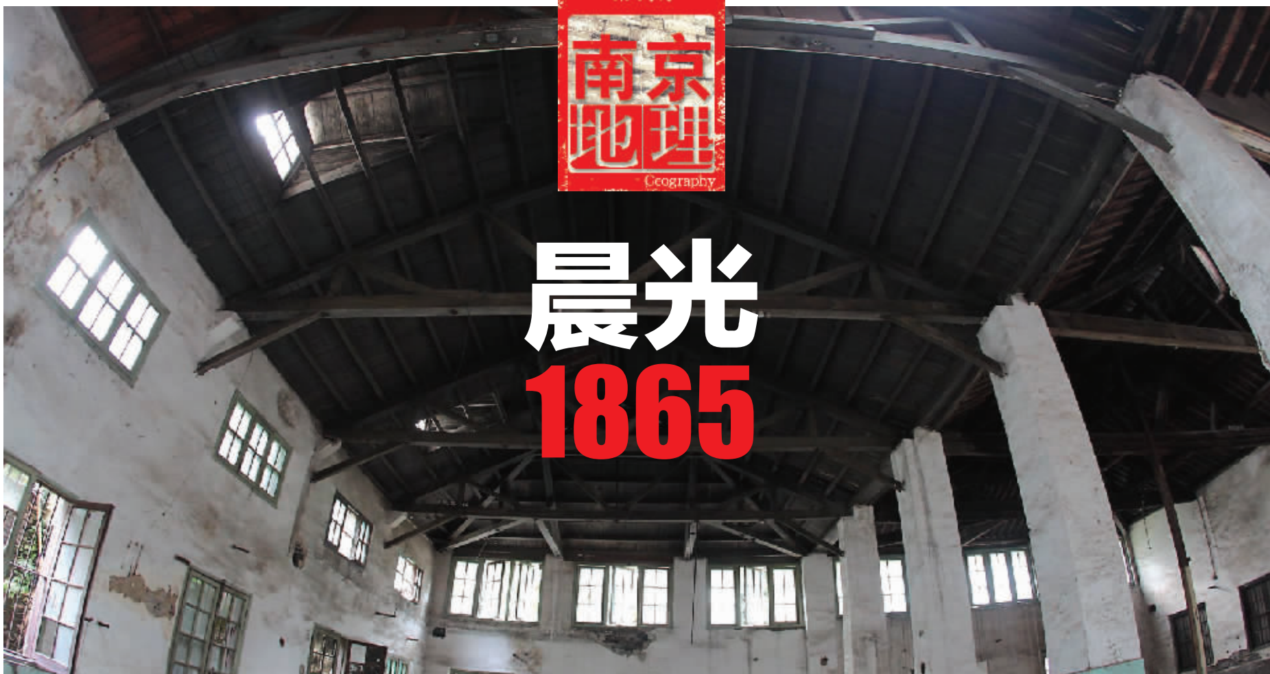
在一间清朝厂房内,后加的吊顶全部拆掉,重新裸露出巨大的木质斗拱横梁
