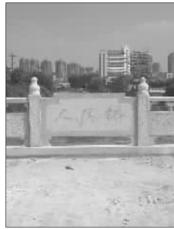
因为没有事先沟通,西门桥安装的桥名牌还是人民桥 匡笠 摄
