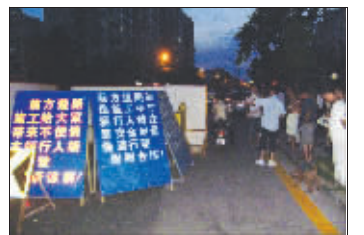
路口竖起围挡正在抢修
