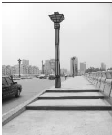
胜太桥的人行道没有盲道和坡道
