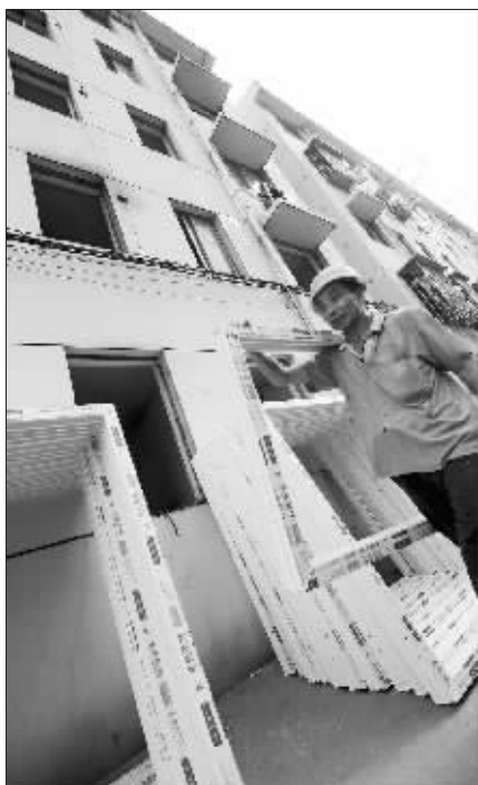
施工人员运来新的门窗 快报记者 赵杰 摄
