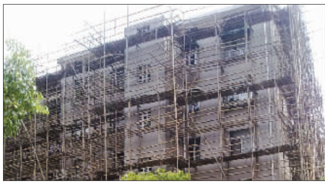
老小区的外墙已经搭满了脚手架
