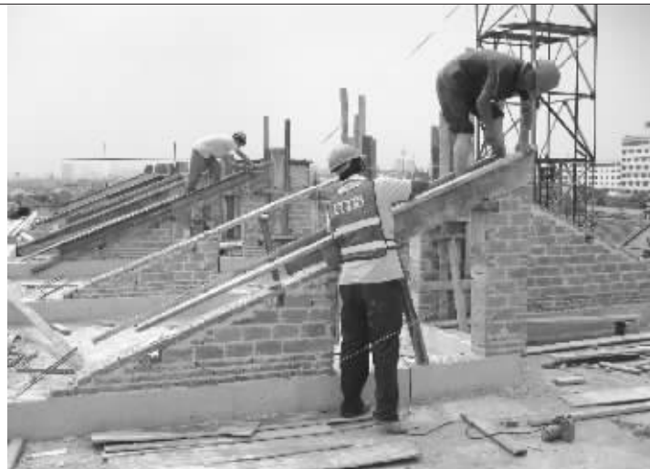
楼顶平改坡现场,温度至少40℃
