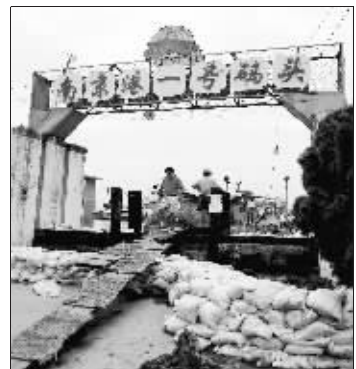
长江南京段超警戒水位,南京港一号码头加固了挡水堤。新华社
