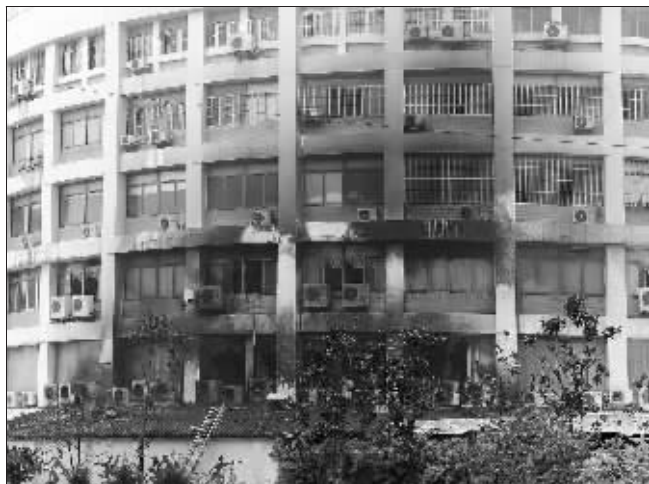
大楼外墙被熏得乌黑 快报记者 施向辉 摄
