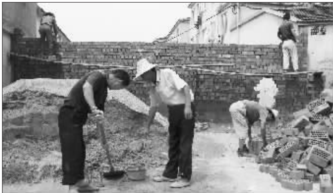
工人正在文荟路上砌墙
