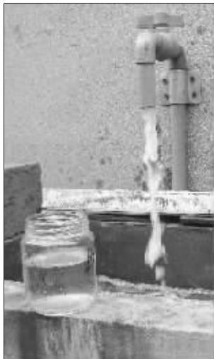
环保部门通过龙宇公司厂外引流管监测污水指标
