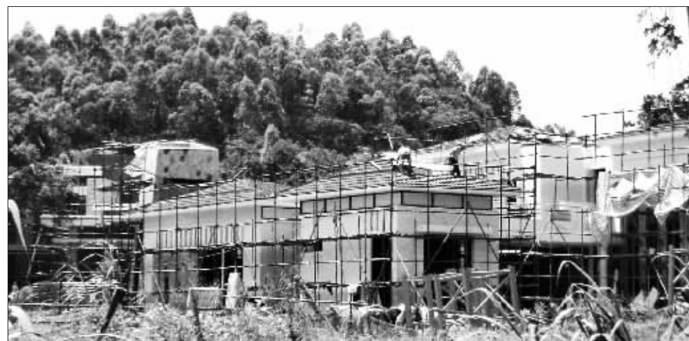
正在施工的“大一山庄”项目
