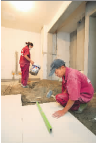
龙瑞装饰明星施工队在施工
