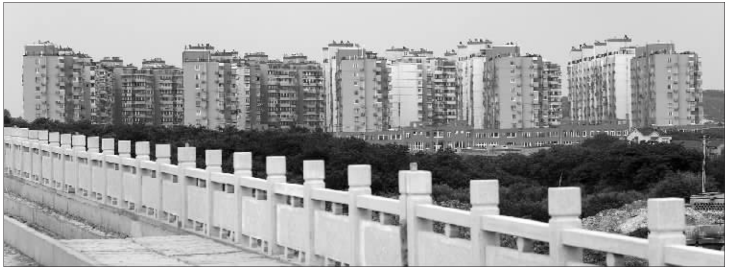
南京正在建设中的经济适用房“西善花苑”小区 快报记者 施向辉 摄
