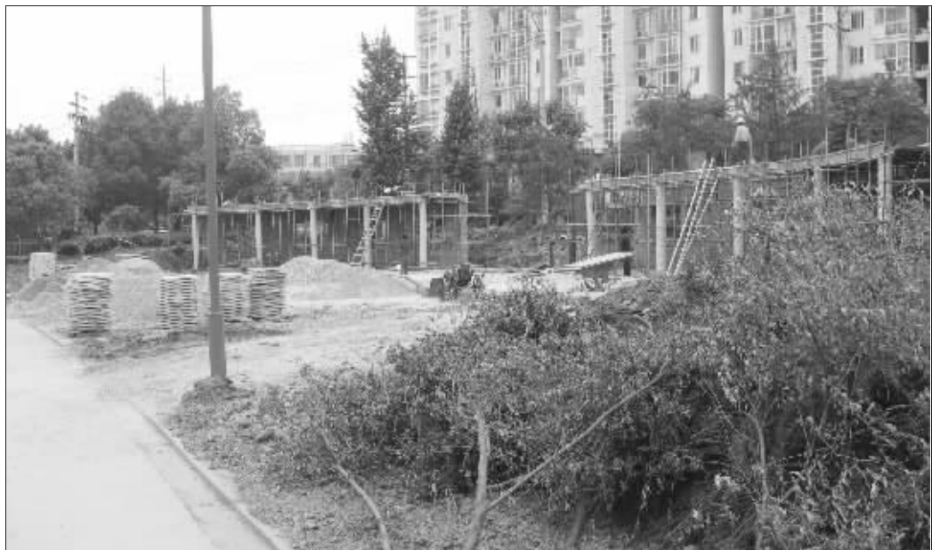
公园改造将原来的一些绿化挖掉,图为施工现场
