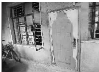
承重墙上开门
