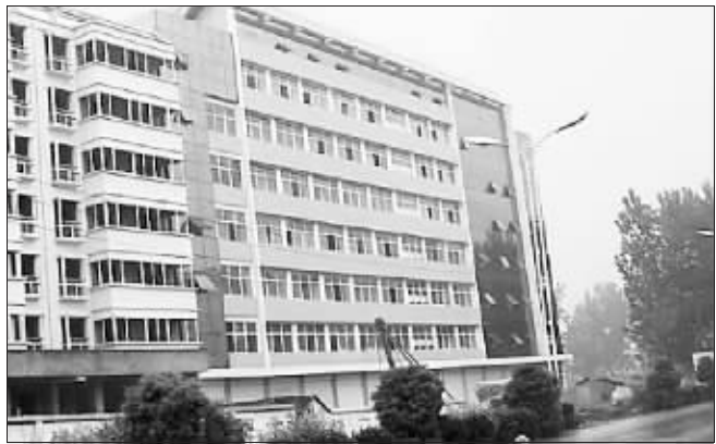
正在装修的嵩县审计局办公楼
