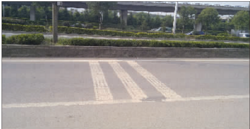
这样的减速震荡线在玄武大道高架上有好几条。快报记者 朱俊俊 摄
