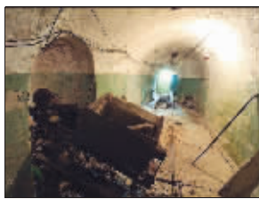
隧道内自制的混凝土搅拌机
