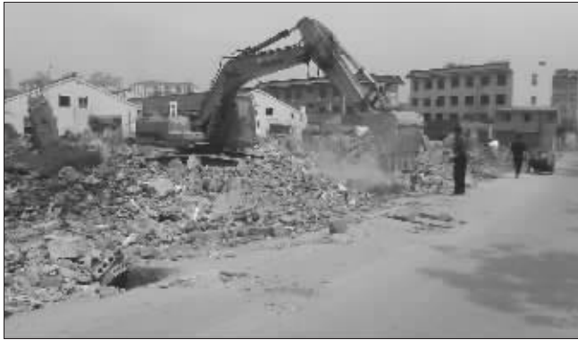
广丰桥附近拆迁工地施工无围挡
