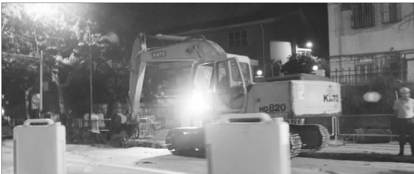
深夜正在施工的挖掘机 快报记者 是钟寅 摄
