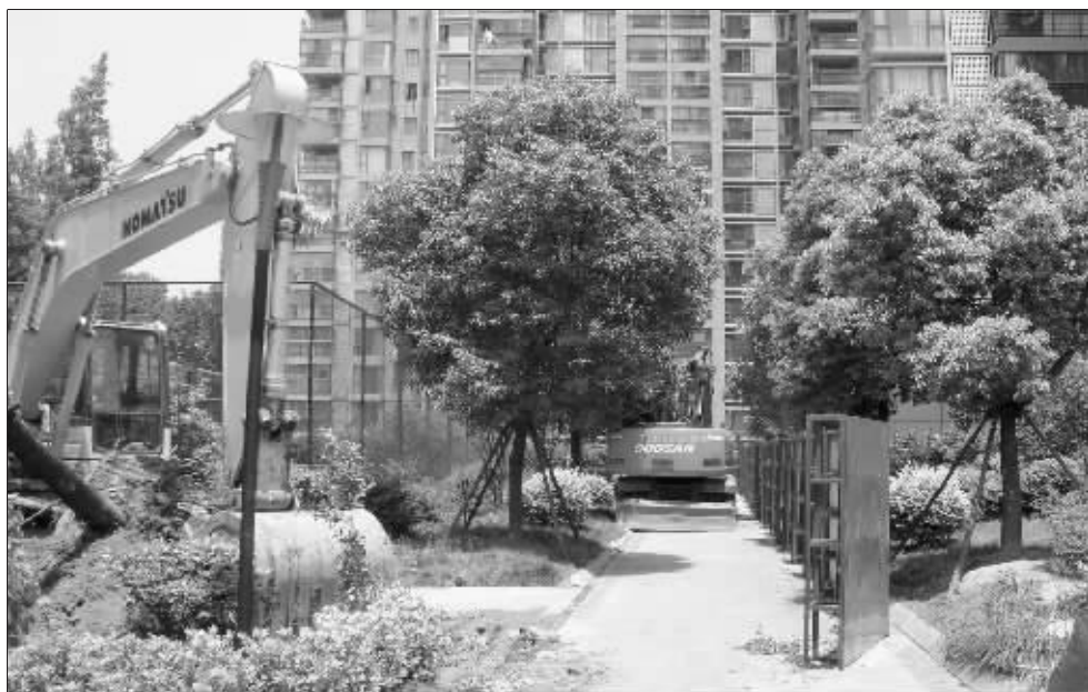
施工机械已在居民楼附近开始施工 快报记者 辛一 摄
