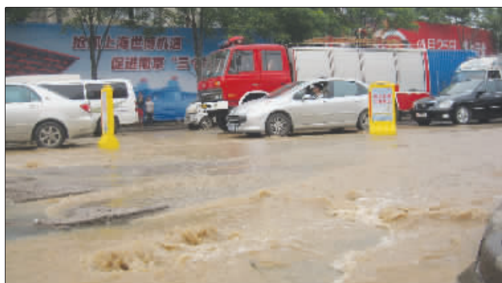
地面塌了一个桌面大小的洞(左图);路面成泽国(右图)
