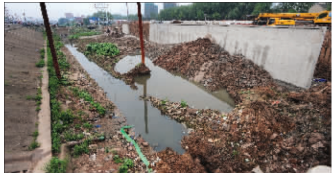
南河截断施工 快报记者 施向晖 摄
