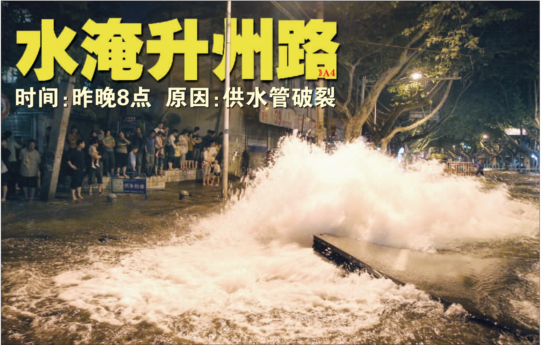
昨晚，被凿破的水管不断喷发出水流，积水几乎淹没半条升州路 快报记者 辛一 摄
