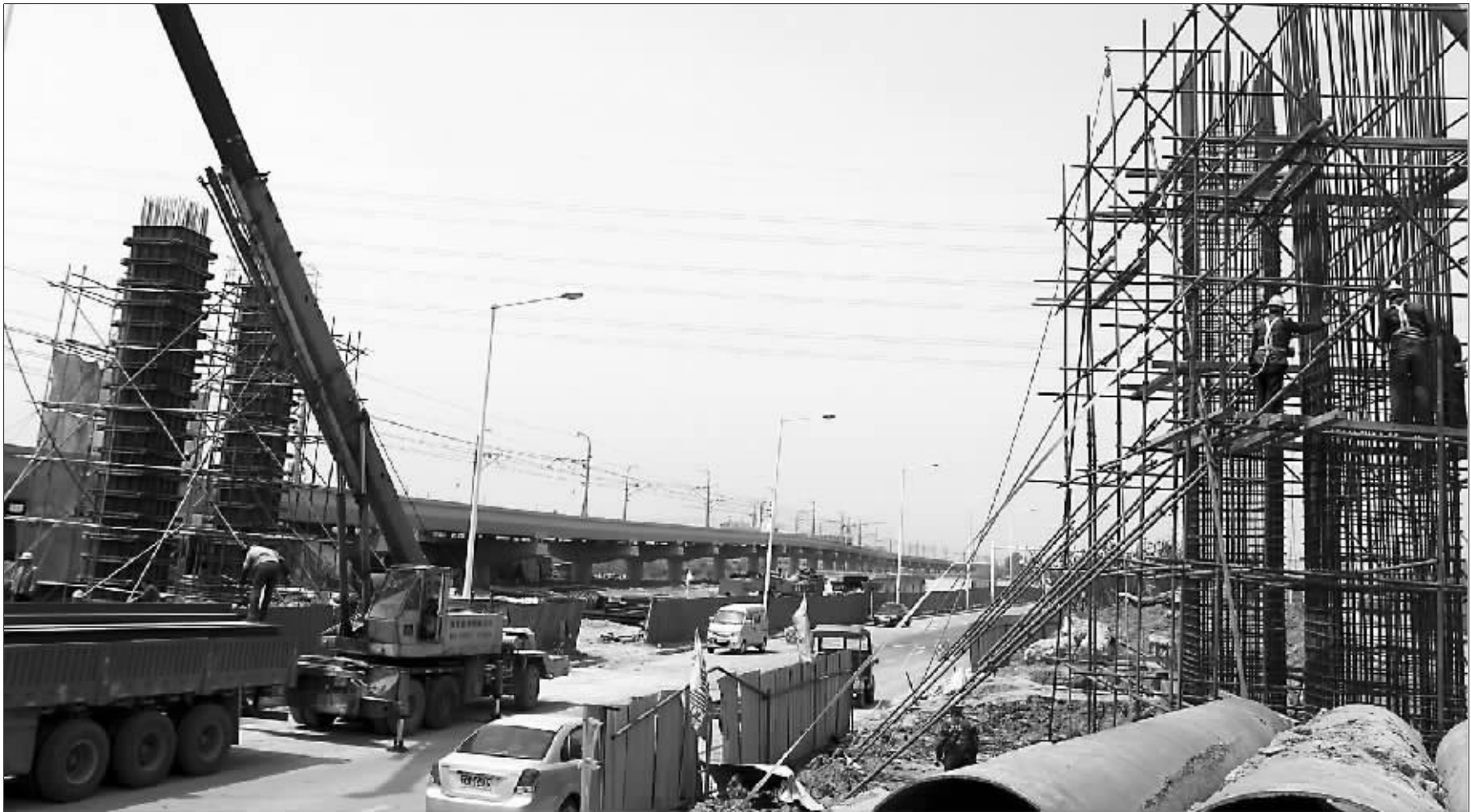
南京长江四桥高速将在仙林大道跨越地铁2号线东延线高架(图为施工现场) 快报记者 顾炜 摄
